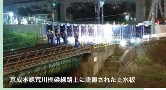
京成本線荒川橋梁線路上に設置された止水板
