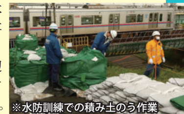
※水防訓練での積み土のう作業
