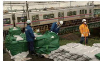
大型土のうを設置する区職員
